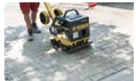
Abrütteln in ungebundener Bauweise
