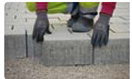
Verlegen in ungebundener Bauweise
