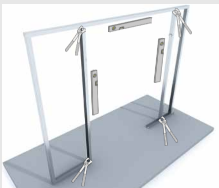
Montageöffnung vorbereiten
